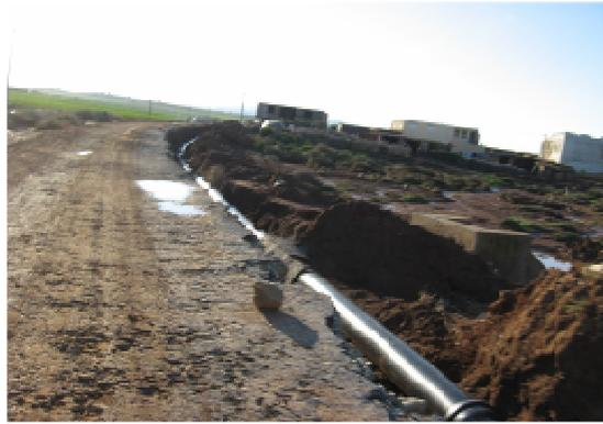
*Photo 11 : Réalisation d'une canalisation par FADESA pour pomper l'eau de la Moulouya*
