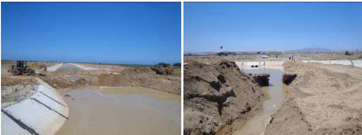
*Photo 19 et 20 montrant la mobilisation des engins pour l'ouverture d'une brèche dans le canal et la réalisation de deux bâtardeaux d'eau pour permettre l'alimentation du bras mort de la Moulouya.*
