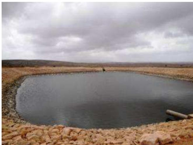
*Photo 13: STEP de Saïdia avec la conduite de déversement et la conduite d'évacuation du trop plein dans la nature vers le marécage de Charba, zone humide du Sibe de la Moulouya.*
