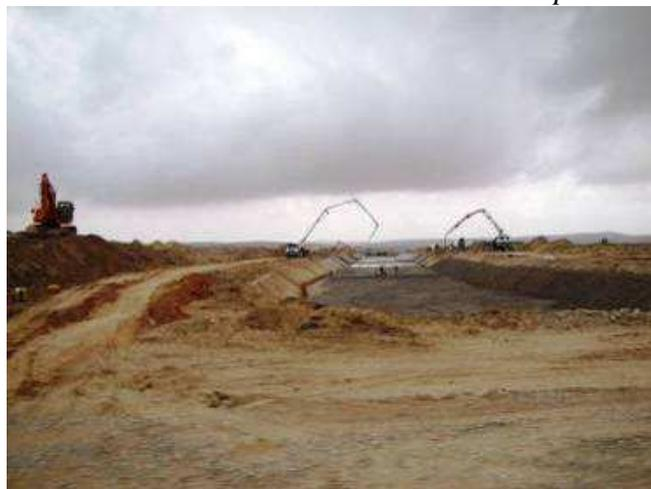
*Photo 17 : montrant le bétonnage du canal d'évacuation des crues au niveau du Sibe de la Moulouya au voisinage immédiat de l'embouchure de la Moulouya.*
